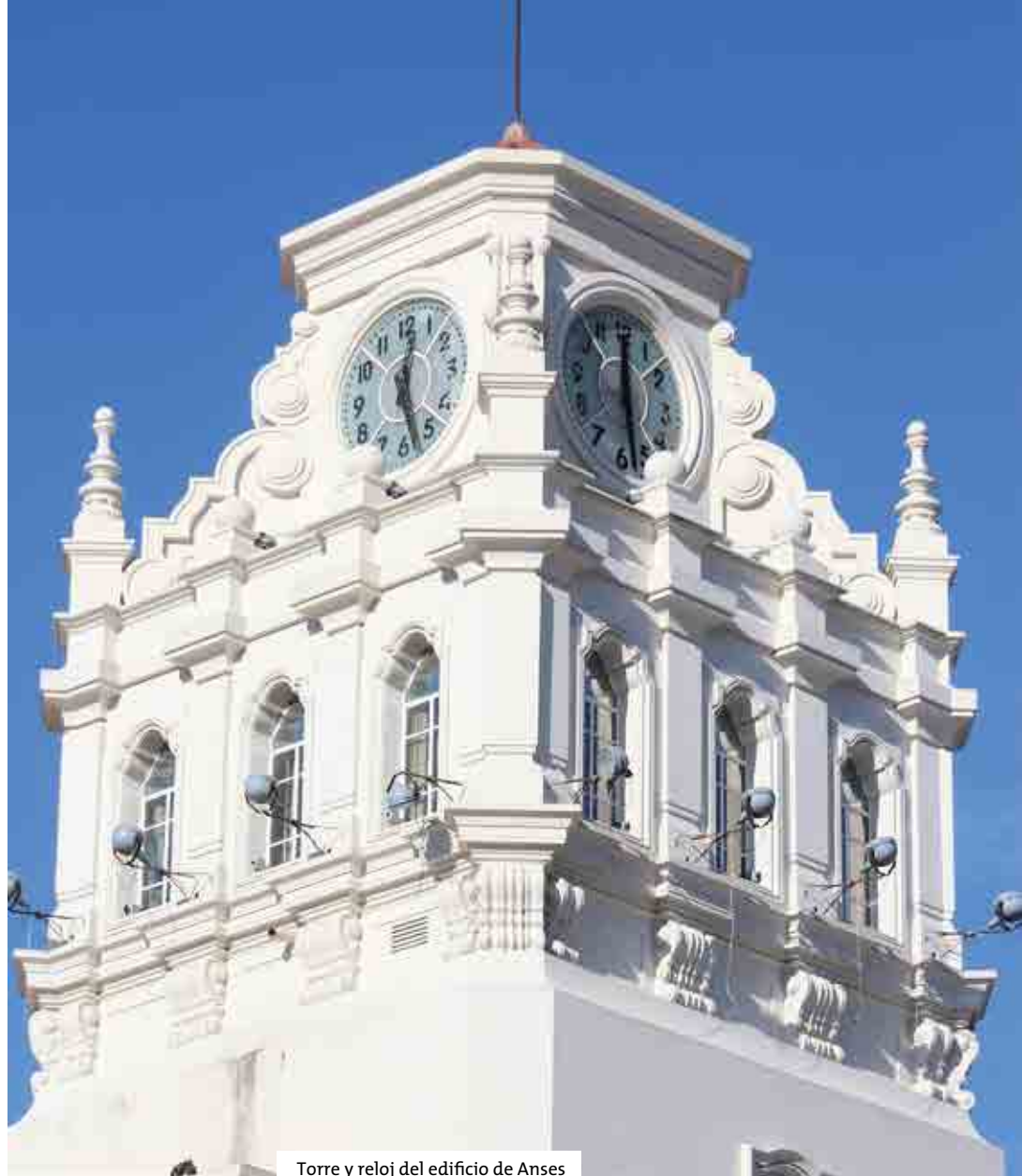
Torre y reloj del edificio de Anses
