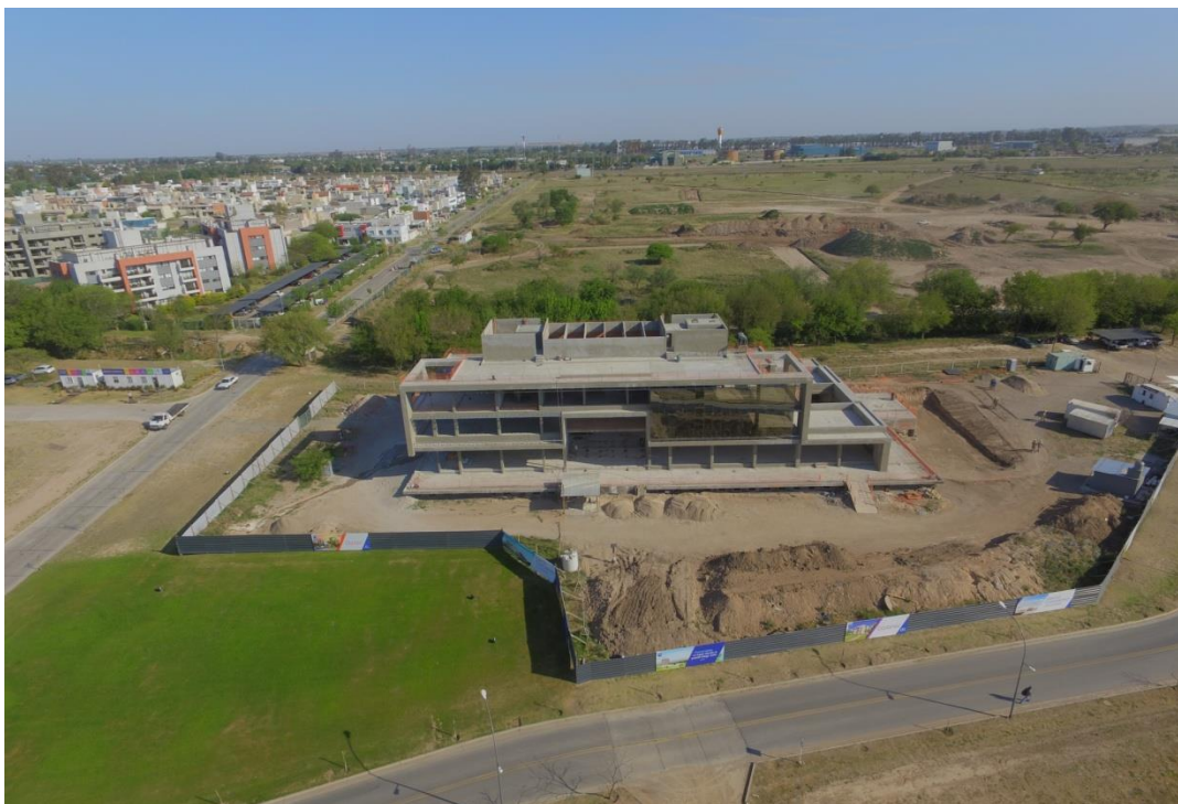
Avance de obra a octubre de 2016
