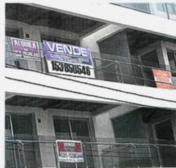
Sin escritura. Uno de los problemas en inmuebles nuevos, como Castelli
